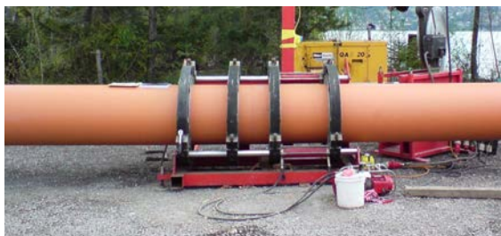
Heizelementstumpfschweißen
